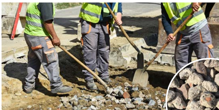
Einsatz von Betonmineralgemisch im Straßenunterbau
