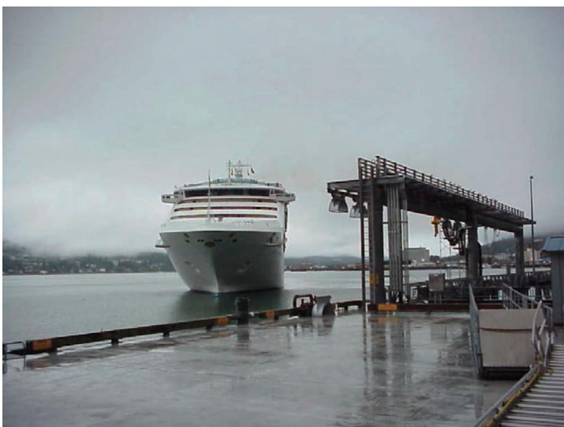
Bild 17 - Anschluss mittels Kabelbrücke im Hafen von Juneau
