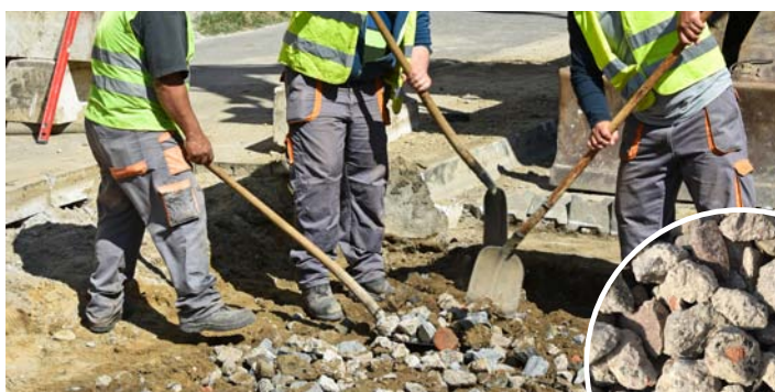
Einsatz von Betonmineralgemisch im Straßenunterbau
